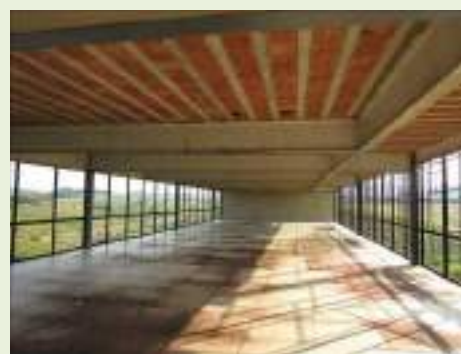
Vista do prédio administrativo - 1º pavimento superior
