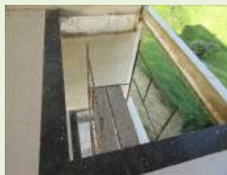
Vista do prédio administrativo - 2º pavimento superior
