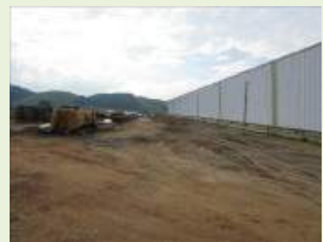
Vista geral interna
