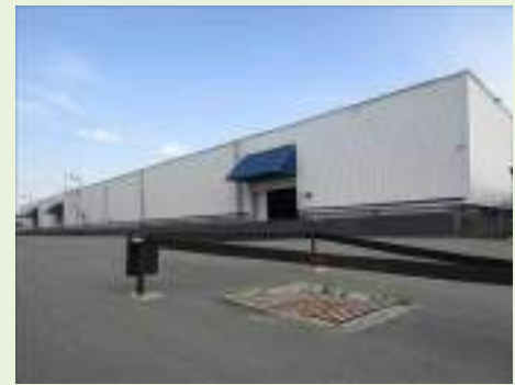
Vista geral interna
