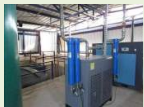
Vista geral interna
