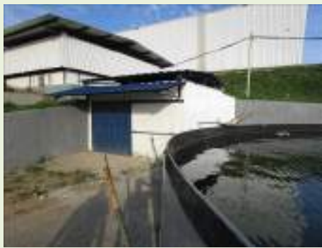
Vista geral interna
