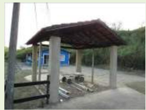
Vista geral interna
