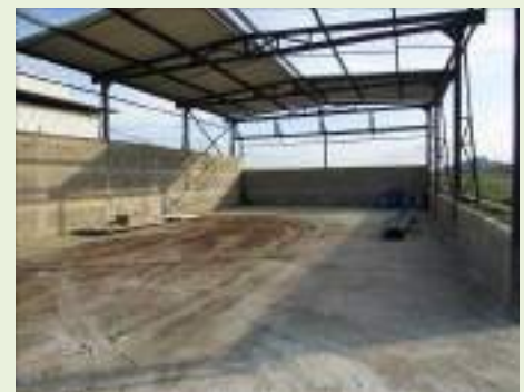
Vista geral interna
