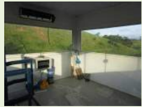
Vista do pórtilco - portaria
