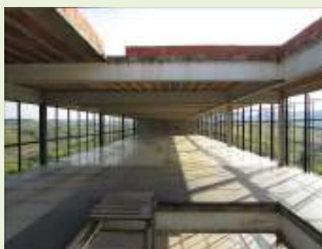
Vista do prédio administrativo - 2º pavimento superior
