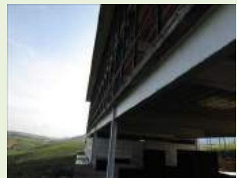
Vista do prédio administrativo - térreo
