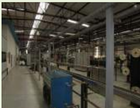
Vista do galpão fabrica
