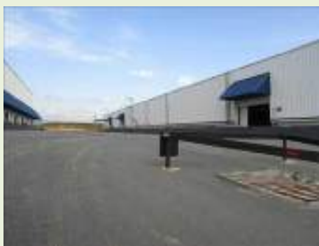
Vista geral interna
