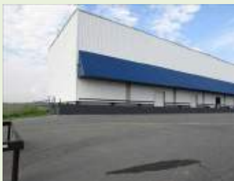
Vista geral interna
