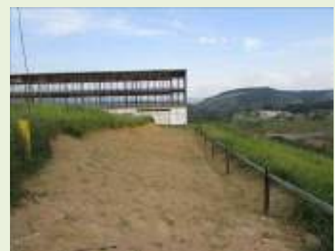
Vista geral interna
