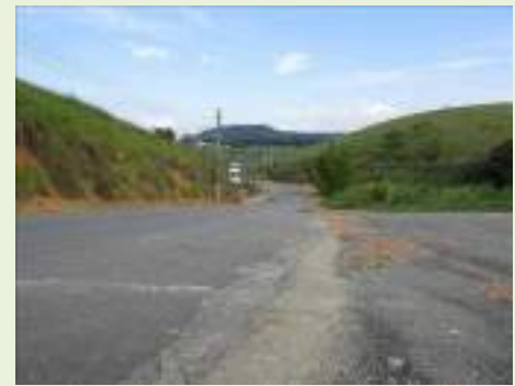
Vista geral interna
