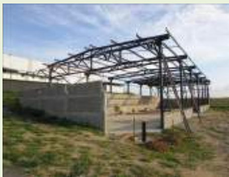
Vista geral interna
