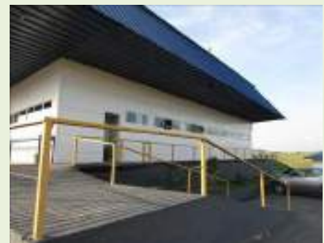
Vista do galpão estoque
