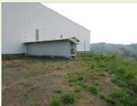
Vista geral interna
