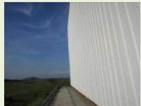
Vista do galpão estoque
