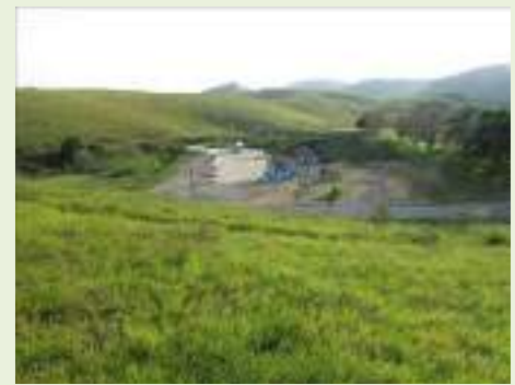
Vista geral interna
