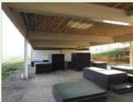
Vista do prédio administrativo - térreo
