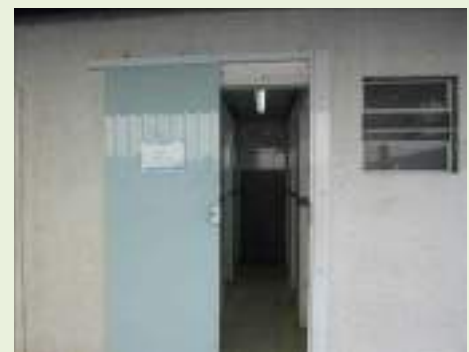
Vista do refeitório e vestiário
