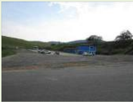
Vista geral interna
