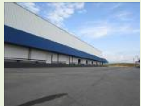
Vista geral interna
