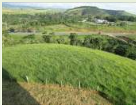
Vista geral interna
