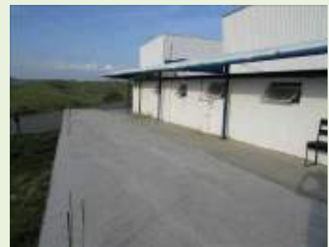
Vista geral interna
