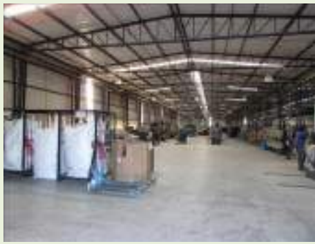
Vista do galpão fabrica
