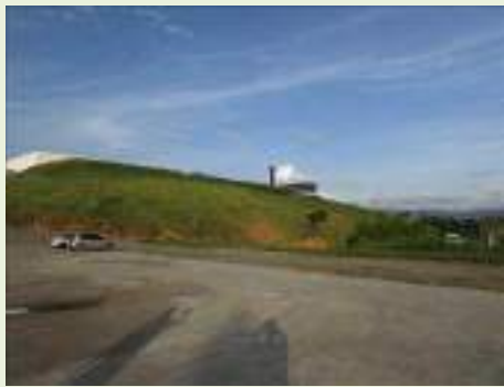
Vista geral interna
