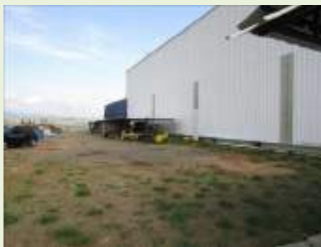
Vista geral interna
