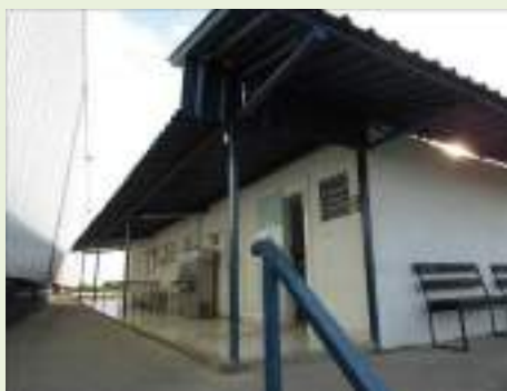
Vista do refeitório e vestiário
