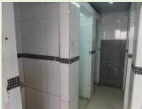
Vista do refeitório e vestiário
