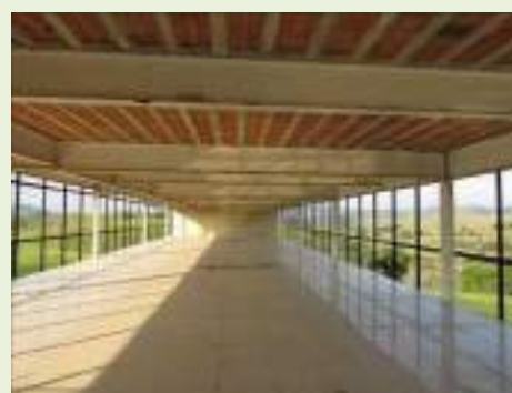
Vista do prédio administrativo - 1º pavimento superior
