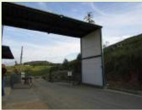
Vista do pórtico - portaria
