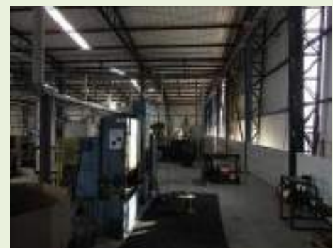
Vista do galpão fabrica
