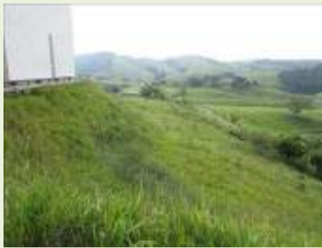
Vista geral interna
