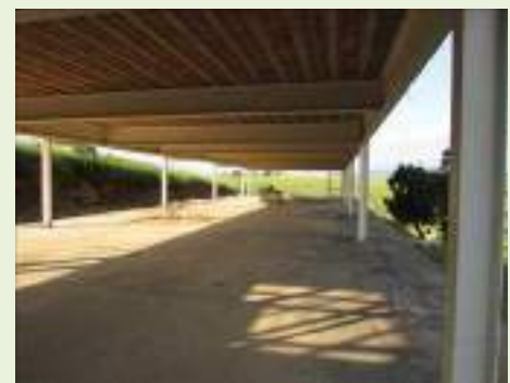
Vista do prédio administrativo - térreo
