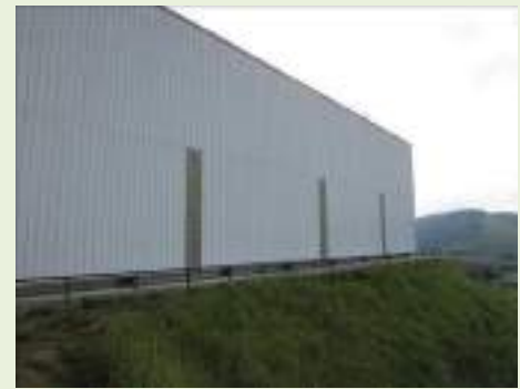
Vista geral interna
