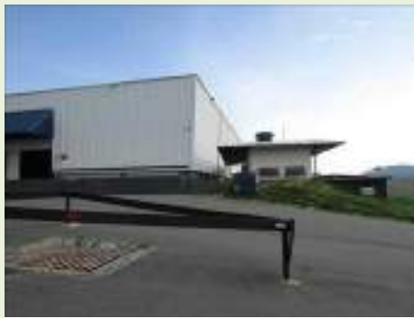
Vista geral interna
