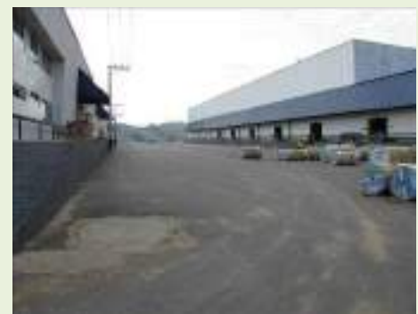
Vista geral interna
