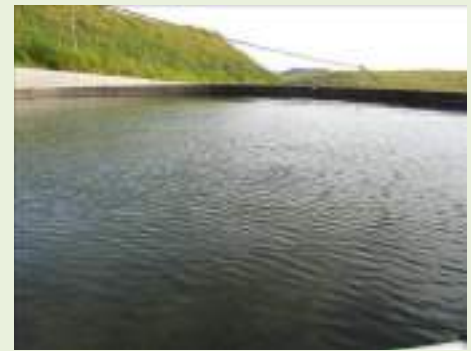
Vista geral interna
