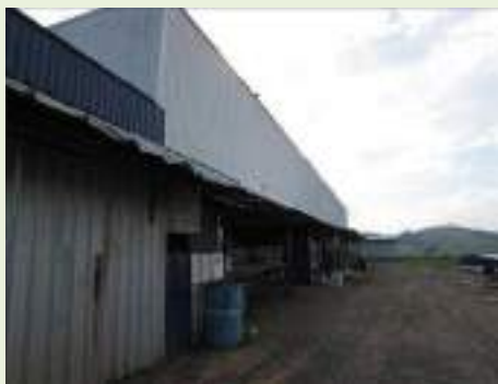
Vista geral interna
