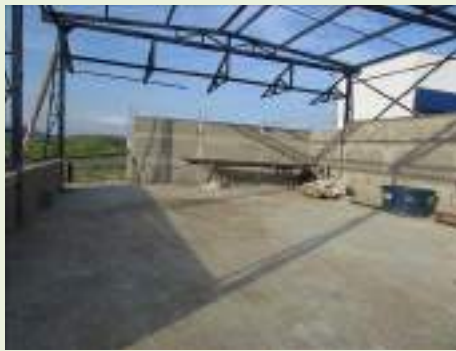
Vista geral interna
