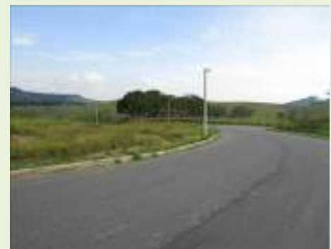
Vista geral interna
