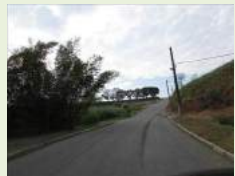
Vista geral interna
