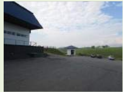
Vista geral interna
