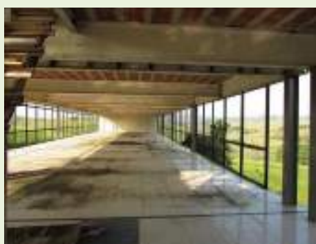
Vista do prédio administrativo - 1º pavimento superior
