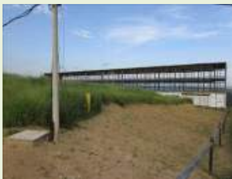
Vista geral interna
