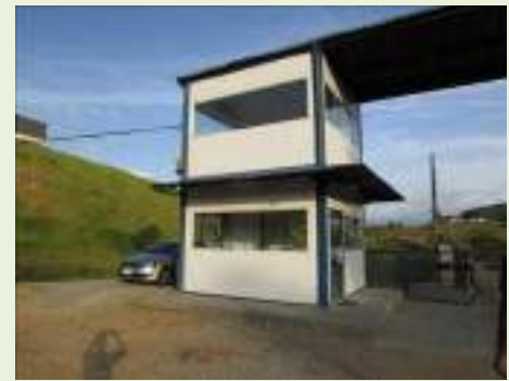
Vista do pórtico - portaria
