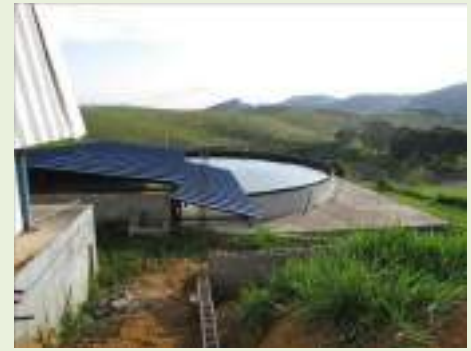
Vista geral interna
