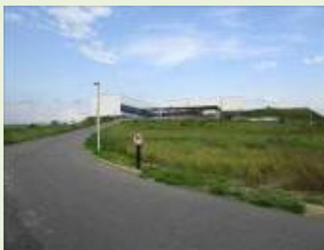
Vista geral interna
