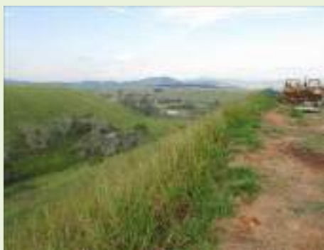
Vista geral interna
