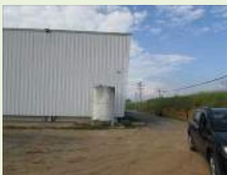
Vista geral interna
