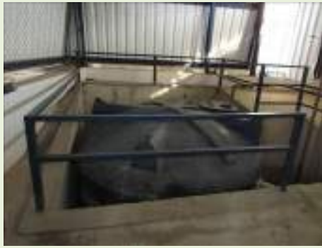
Vista geral interna
