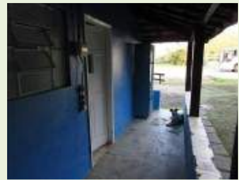
Vista do administrativo
