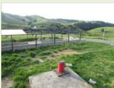
Vista geral interna
