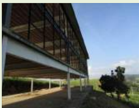
Vista do prédio administrativo - térreo
