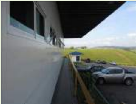
Vista do galpão estoque
