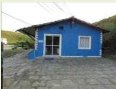
Vista do administrativo
