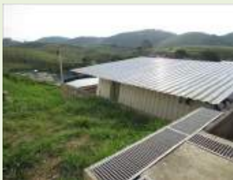
Vista geral interna
