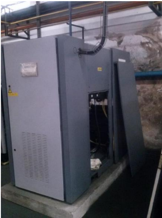
Compressor de ar de baixa GA 37 ATLAS COPCO Nº Serie BRPO 72007 Ano 2009
