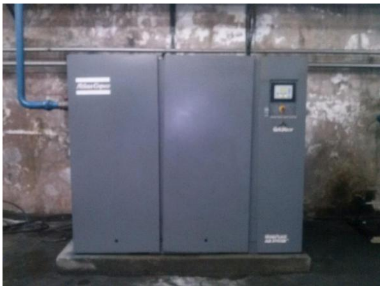
Um Compressor de Baixa GA 90 Atlas Copco Nº serie BRP 067062 Ano 2007
