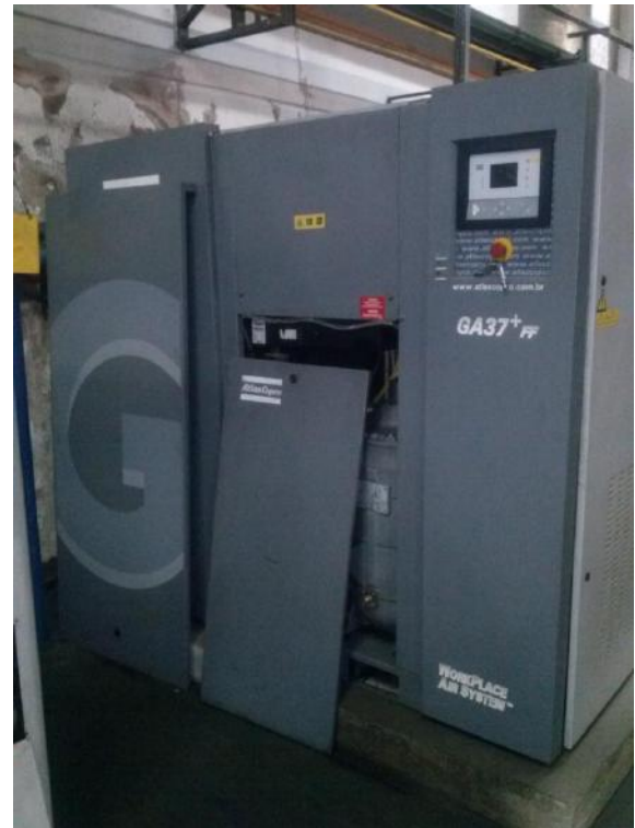
Compressor de ar de baixa GA 37 ATLAS COPCO Nº Serie BRPO 72007 Ano 2009
