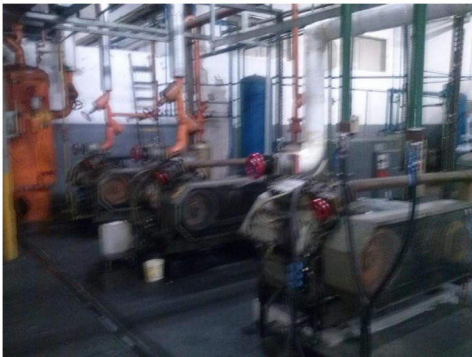
Três Compressores de amônia Modelo SMC 108 S
